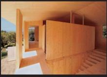
Sie werden mit einer Maximallänge von 16.50 m, einer Maximalbreite von 2.95 m und einer maximalen Plattenstärke von 0.50 m unter permanenter Eigenund Fremdüberwachung produziert.
