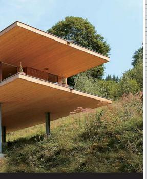
Die Großformatigkeit der KLH Massivholzplatten, deren Scheibenwirkung und statische Belastbarkeit sowie die Möglichkeit sie mit Stahl, Glas als auch allen anderen üblichen Baumaterialien zu kombinieren bieten größtmögliche Freiheit in der Architektur. Beginnend vom Einfamilienhaus, über den mehrgeschossigen Wohnbau, dem sozialen Bauwesen bis hin zu Industriebauten, überspannten Decken- und Brückenkonstruktion.
