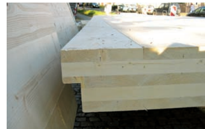
Detail masivní panelové konstrukce z lepeného dřeva
